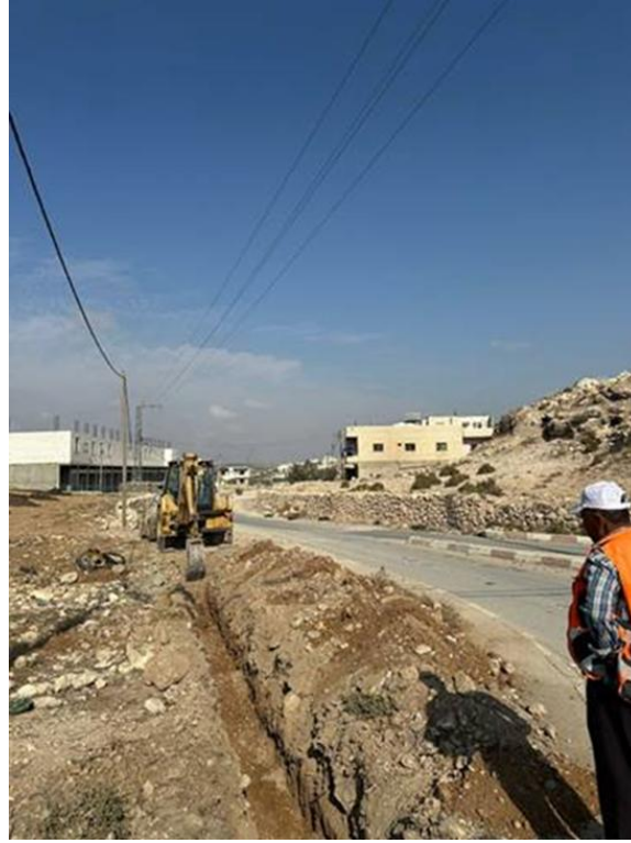
صورة: التجهيز لتركيب خط ناقل للمياه في دير سامت
